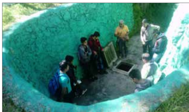
Figura 5. Caja de captación establecida por el Comité de agua de Juchanep. Foto: SAC-CDRO
